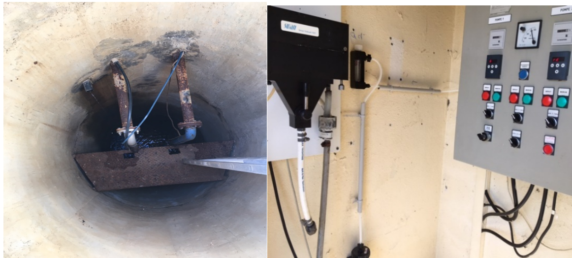
Site du puits de Lézan, affichage et installations
